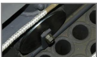
Bei der Reinigung des Wärmetauschers (Bild 3/23) ist auf eine saubere Fläche der Rauchgasklappe zu achten (Bild 3/15). Eventuelle Undichtheit kann zu einer Reduzierung der Kesselleistung führen.
