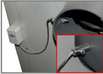
Ein sauberer und staubfreier Abgasfühler ist Bedingung für dessen zuverlässigen Betrieb. Bei der Reinigung des Wärmetauschers ist auch der Staub aus dem Abgasfühler zu beseitigen.
