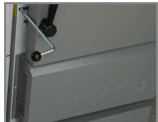
Um eine optimale Verbrennung im Kessel zu gewährleisten, ist die richtige Einstellung der Sekundärluft sehr wichtig. Das Verhältnis zwischen der Primär- und Sekundärluft mithilfe von Schrauben „1“ fix eingestellt. Optimale Einstellung der Sekundärluft ist ab Werk 2,5 Umdrehungen. Vorgehensweise bei eventueller Änderung oder Kontrolle:
