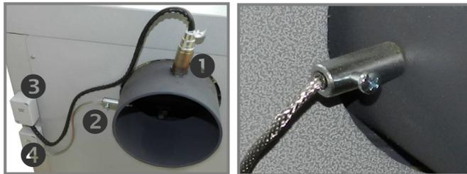
Eine saubere und staubfreie Lambdasonde und Abgasfühler sind Bedingungen für deren zuverlässigen Betrieb. Bei der Reinigung des Wärmetauschers ist auch der Staub aus der Lambdasonde „1“ und dem Abgasfühler „2“ zu beseitigen.
