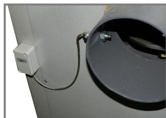
Для правильной функциональности термометра продуктов сгорания очень важна его чистота.
