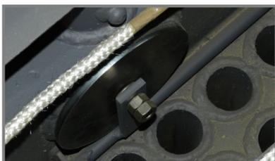
При очистке труб теплообменника (рис. 3/23) необходимо смотреть на чистоту площади опоры клапана и самого клапана дымохода (рис. 3/5). Негерметичность может повлиять на снижение мощности котла.
